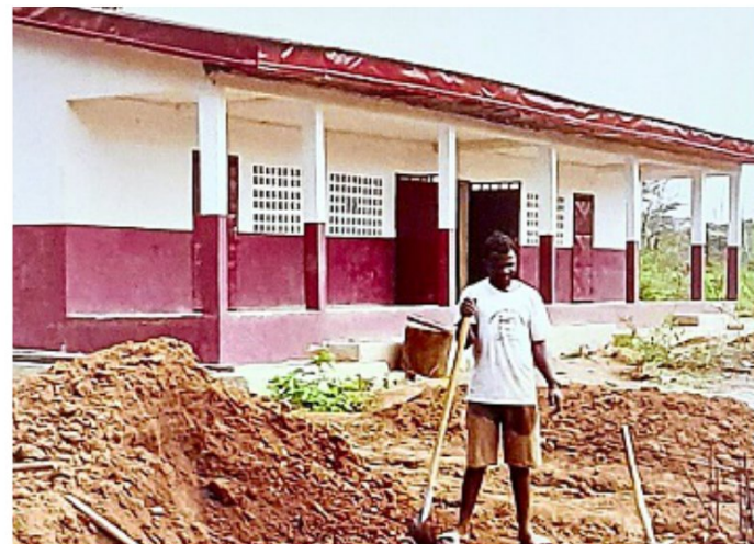
Ein erstes Schulgebäude steht bereits auf dem Gelände in Deuk in Kamerun.
